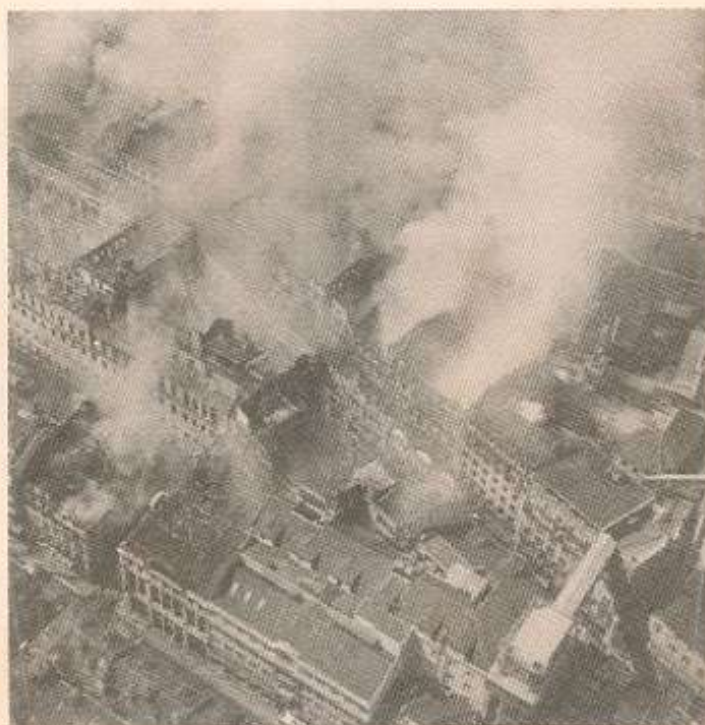
O incêndio destruiu dezoto edifícios no Chiado, dos quais quatro foram demolidos por ameaçarem ruir a qualquer momento.
